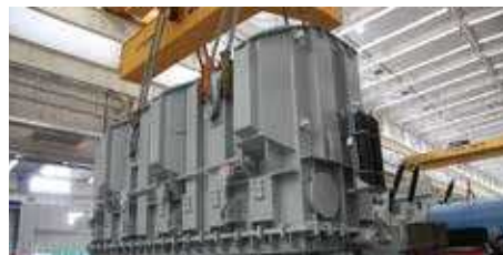
Пуэрто-Рико: трансформатор USA230kV 570MVA
