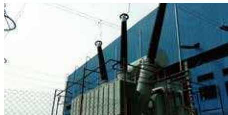
Индия: трансформатор 420kV 60MVA
